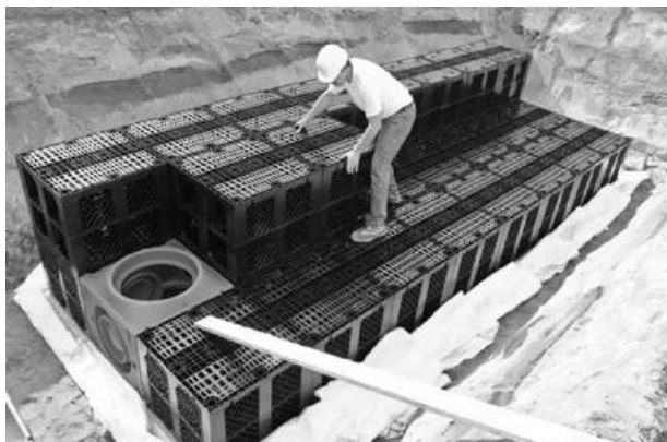
Figur 39: Dagvattenkassetter (www.rehau.com)
